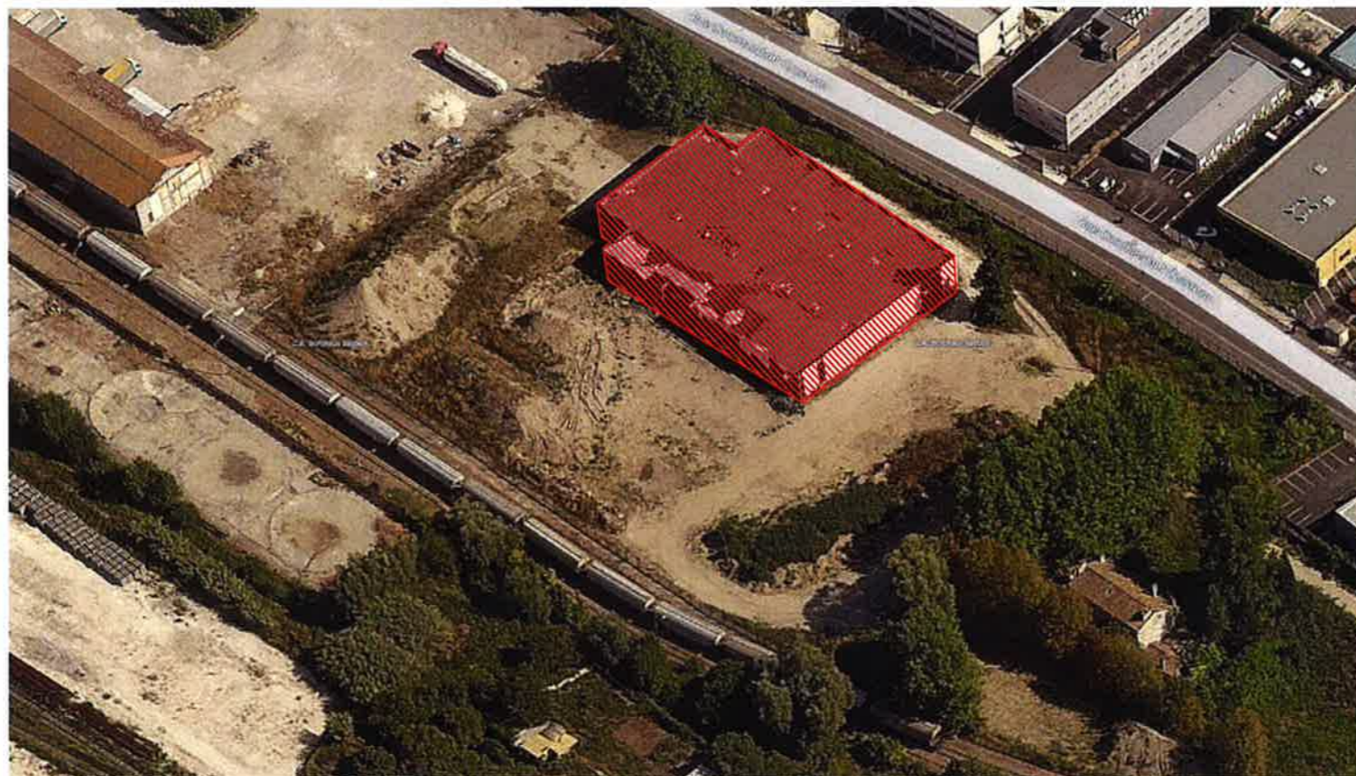
PHOTOGRAPHIE AÉRIENNE DU BÂTIMENT A DÉMOLIR
