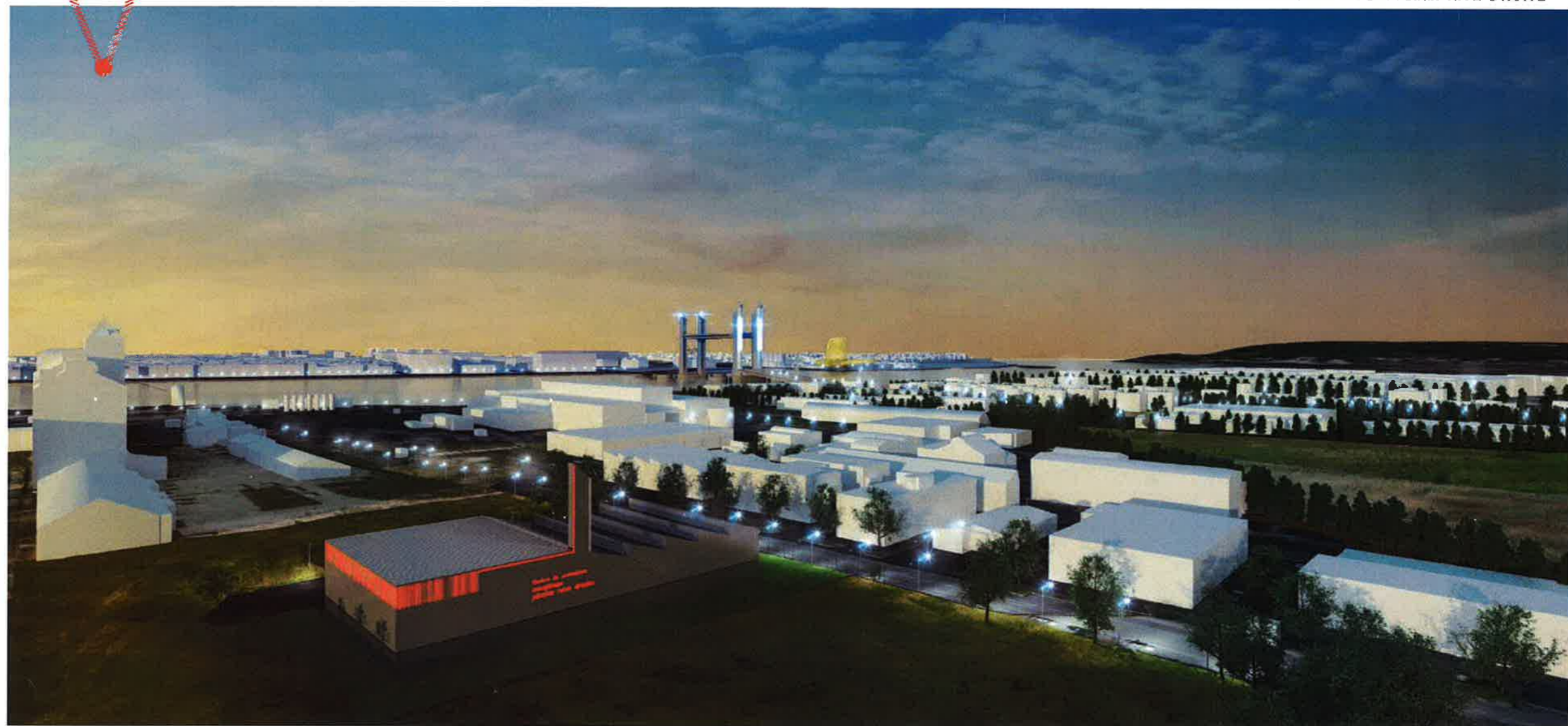
vue aérienne de la chaufferie au coeur de la plaine rive droite
